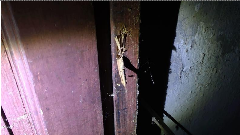
Chaufferie(Sous-sol) : Menuiseries intérieures (Bois)
